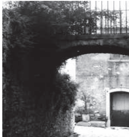
Giardino Flammia La parte posteriore (lato nord) comunica direttamente con gli spazi agricoli ed è collegata a via Limiti. Il giardino è congiunto con il palazzo mediante un ponte sovrastante la strada pubblica.
