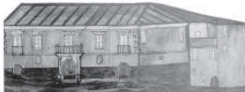
Frigento, “Casa palazziate” del Settecento , attuale farmacia, ristrutturata nella seconda metà del secolo scorso in modo non conservativo.
